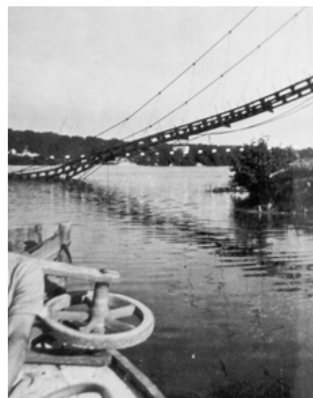
Le 21 août, les Allemands détruisent le pont d'Evry-Etiolles pour freiner l'avancée des troupes américaines.
