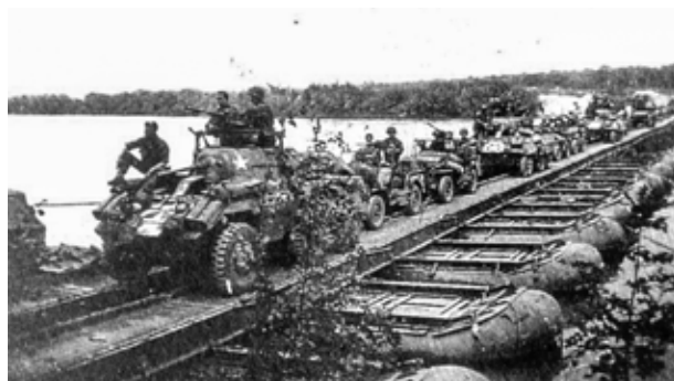
Le 25 août, les troupes américaines franchissent la Seine en utilisant un pont composé de bateaux gonflables reliés entre eux par des poutrelles métalliques.
