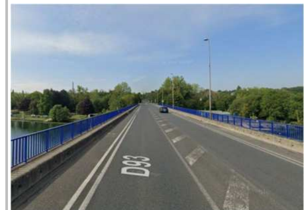
Le passage difficile du pont de l'Avenue Patton – Source : Google Street view, septembre 2022
